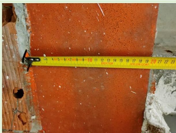
Caracterización de vigas en cara inferior, dimensionado de platabandas.
