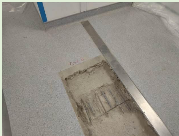
Vista de cata realizada en cara superior de viga
