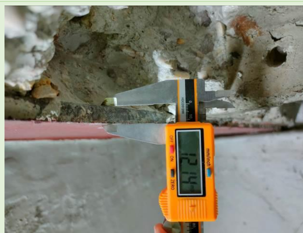
Caracterización de vigas en cara inferior, dimensionado de platabandas.
