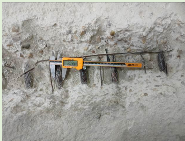
Vista de cata realizada en cara superior de viga
