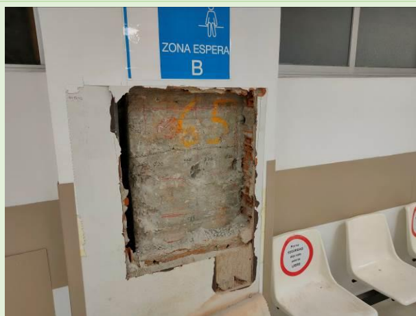
Vista de cata realizada en pilar de planta SS
