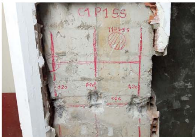
Vista del armado del pilar en cara X
