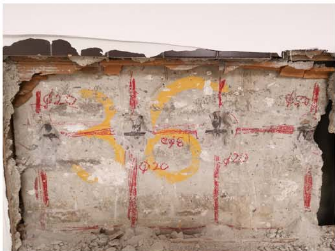
Vista del armado del pilar en cara Y
