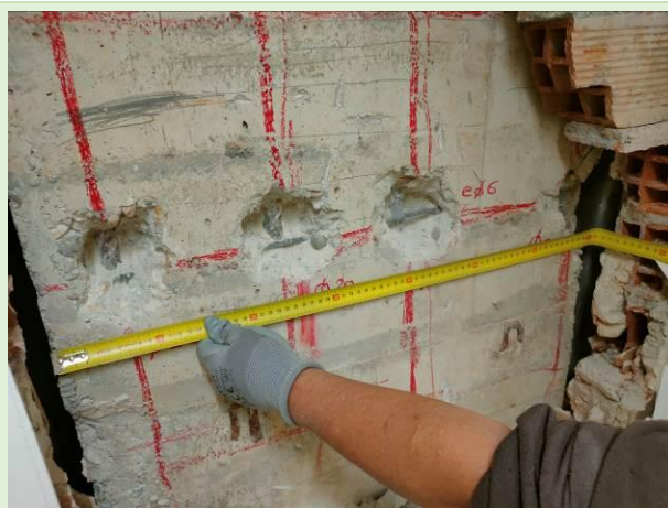
Cata realizada en pilar de planta SS. Dimensiones, armado y espesores de recubrimiento.
