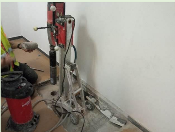
Extracción de probeta testigo en viga V-4.
