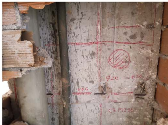
Vista del armado del pilar en cara X
