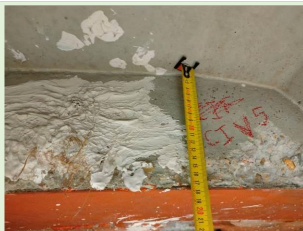
Caracterización de vigas en cara inferior, dimensionado de platabandas.
