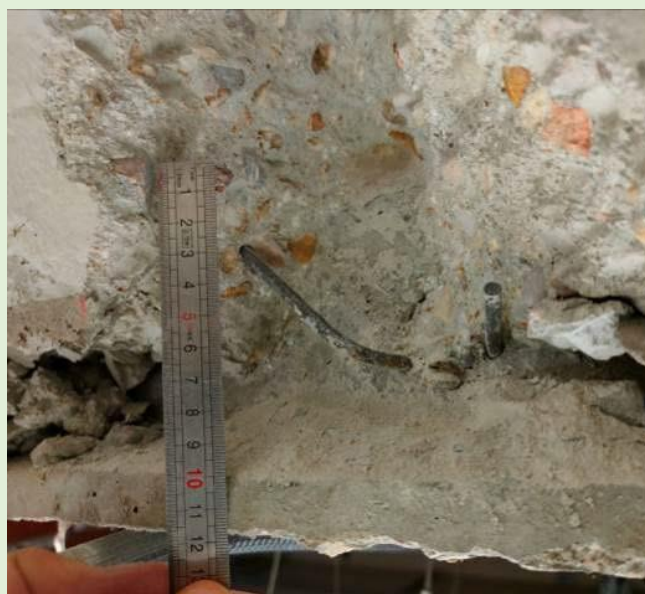
Altura de viguetas pretensada: 12cm
