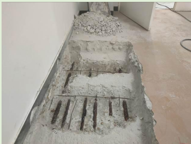
Localización de armadura principal y refuerzos. Medición de diámetros y espesores de recubrimiento.
