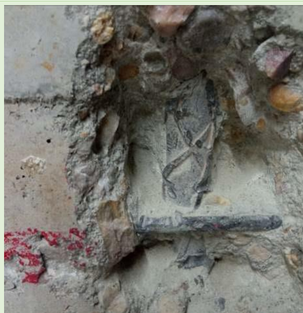
Armado principal Ø20 y estribos Ø6
