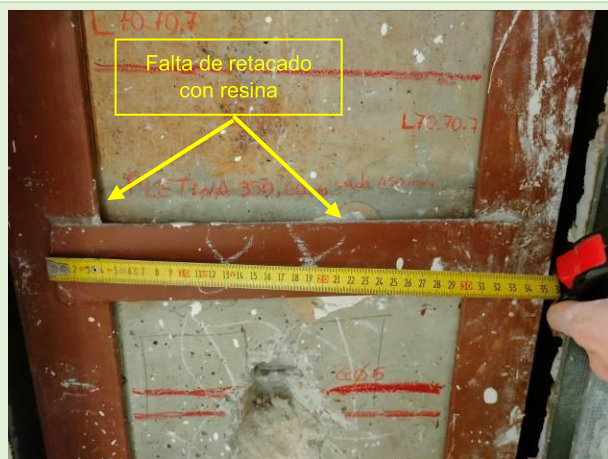
Falta de conexión del refuerzo con pilar.
