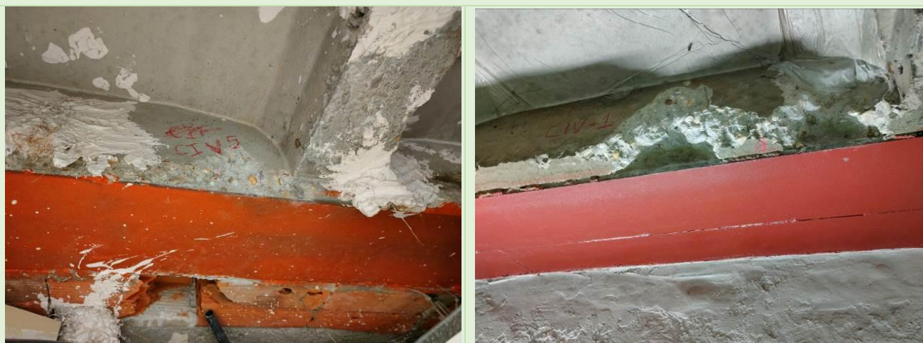
Platabanda metálica en cara inferior de vigas, con espesor y anchura variables.
