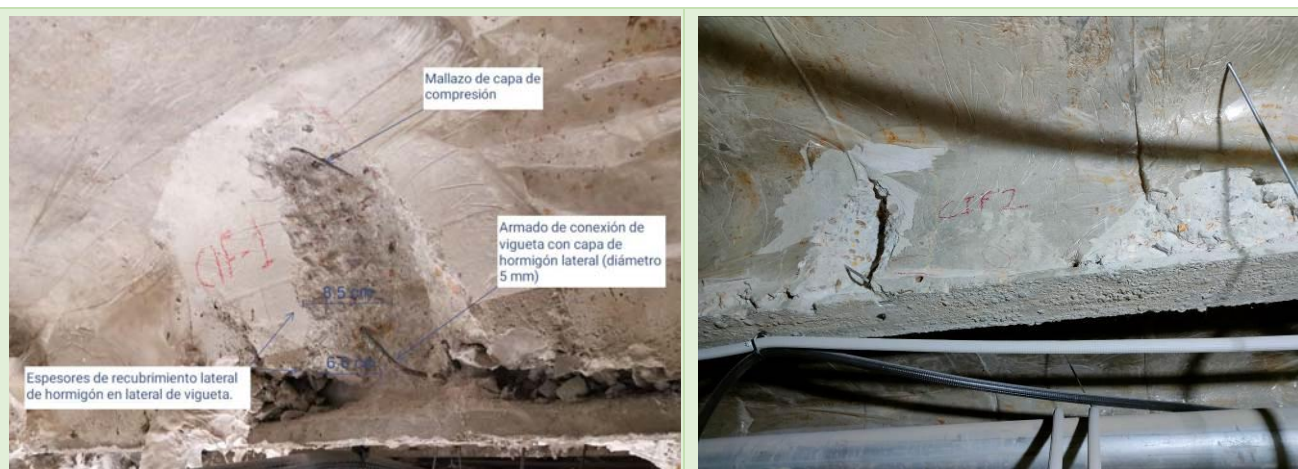
Catas CIF-1 y CIF-2 en las que caracterizamos las viguetas y se localizan los conectores
