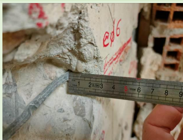
Cata realizada en pilar de planta SS. Dimensiones, armado y espesores de recubrimiento.
